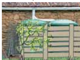
bacs à récupération d'eau
