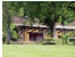
structure en bois
