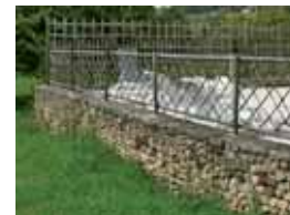
protection de piscine
