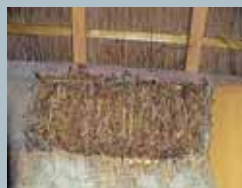
différentes étapes de finition d'un mur en paille
