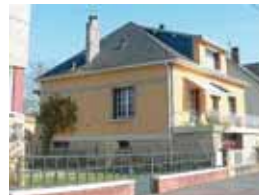
maison des années 50 : forme compacte, étage habitable sur rez-de-chaussée, escalier extérieur et soubassement en pierres
