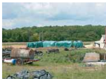
zone de stockage
