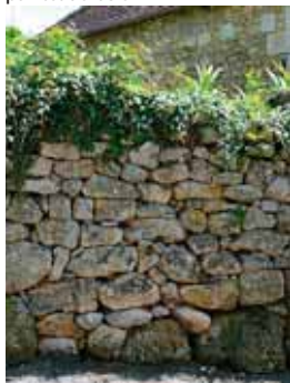
muret en pierre
