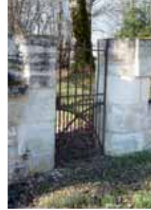
Muret et portillon
