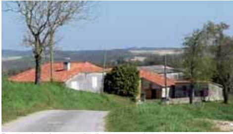
Ferme dans la pente, bâtiments accolés sur 2 côtés
