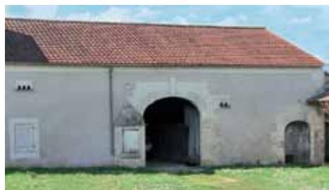
Grange, toit 2 pans, puits bâti, fuies
