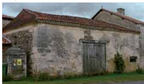
Grange, toit avec croupe tuiles plates
