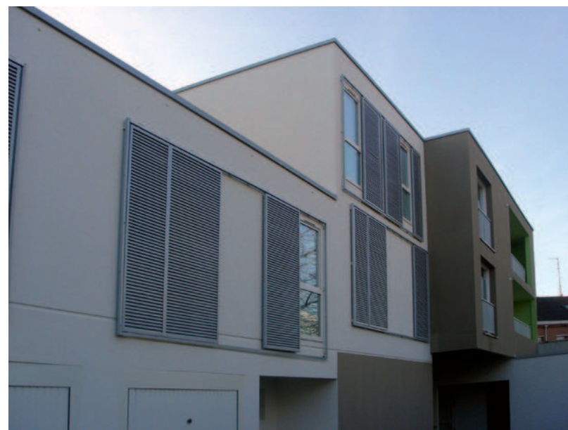
Photos en cours de chantier
