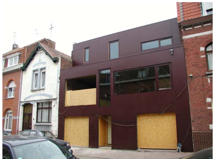
21 septembre 2007 - façade rue
