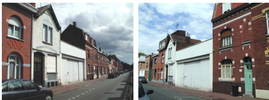
vues de la rue Albert Calmette et du bâtiment a démolir
