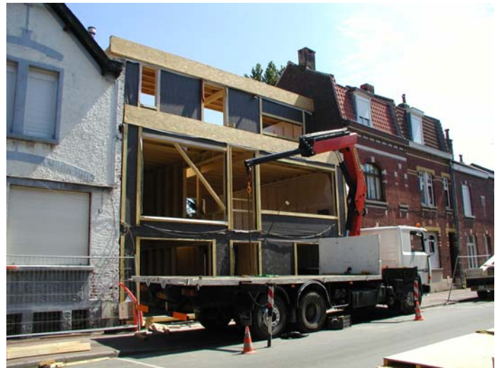
19 juillet 2007 – montage étage 2
