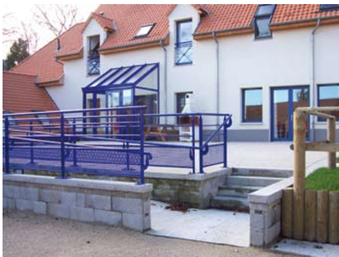
Rampe pour l'accès à la salle
