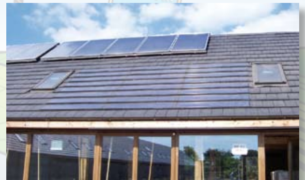
Panneaux solaires et tuiles photovoltaïques, maisons patios.
