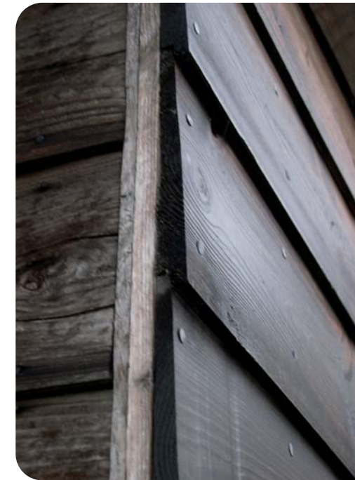
Planches posées à clin (recouvrement partiel)
