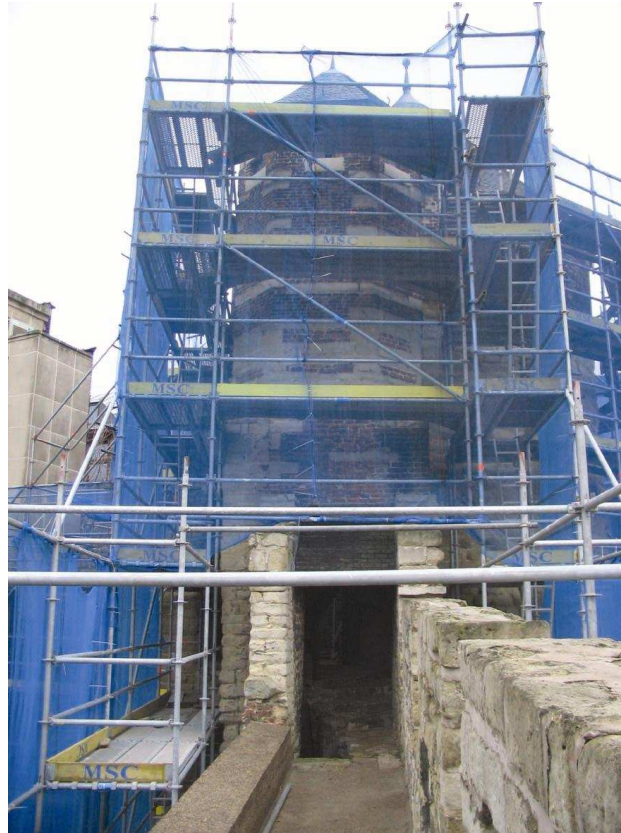
Restauration de la Tour Anneessens
