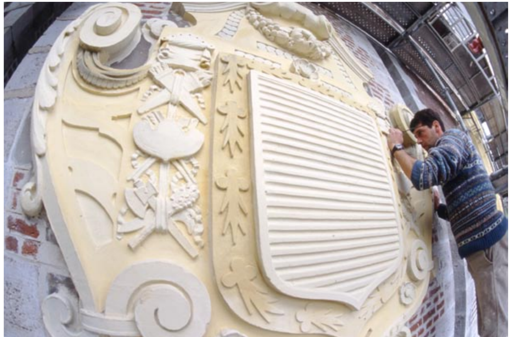
Restauration de la porte de Roubaix dans le cadre de Lille 2004.
