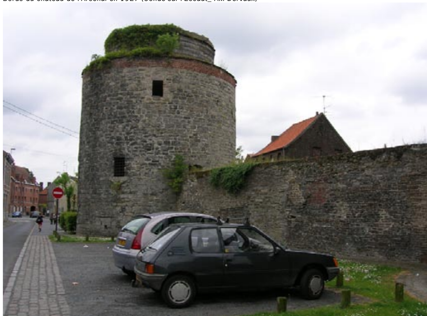
Bords du château de l'Arsenal en 2005 (Photo V. Mermet)
