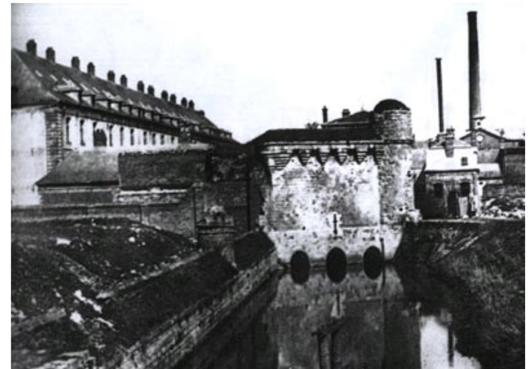
Porte d'eau dite tour des Arquets - Photothèque Augustin Boutique - Grard Douai
