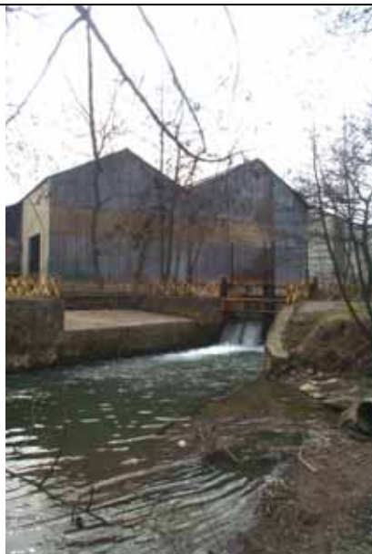
Le site de la digue
