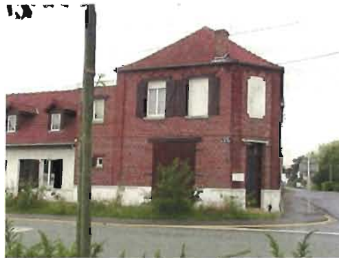
5. Croisement rue de la Borre/rue de Vieux-Berquin
