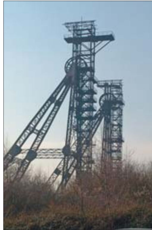
Traces de l'activité industrielle dans le «Grand Charleroi»: les châssis à molette qui «sculptent» le paysage... (Puits 25 dit «Le Pechon» des charbonnages de Monceau Fontaine, à Couillet).
