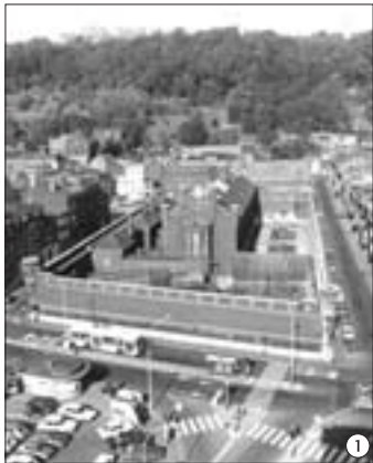
Vue du site peu avant la démolition de la prison (vers 1980) © Ville de Liège
