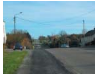
Ondulation du plateau sur la RD 936 à Colleret (le Pavé).
