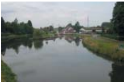
Ecluse de Berlaimont et bâtiments d'activités sur la Sambre entre Aulnoye-Aymeries et Berlaimont.
