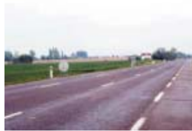
Vue depuis la RD 2 au nord de Maubeuge.
