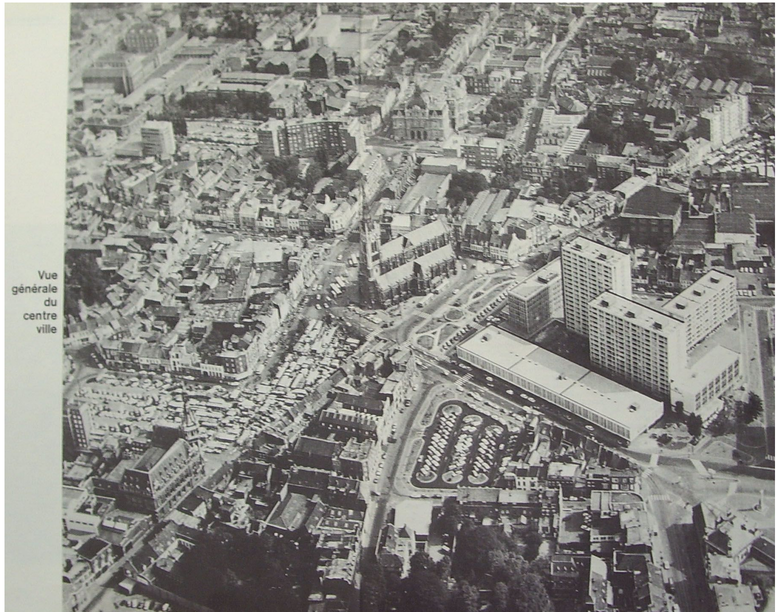
Extrait de "la nouvelle bataille de Tourcoing", Le centre ville et son nouveau centre tertiaire.
