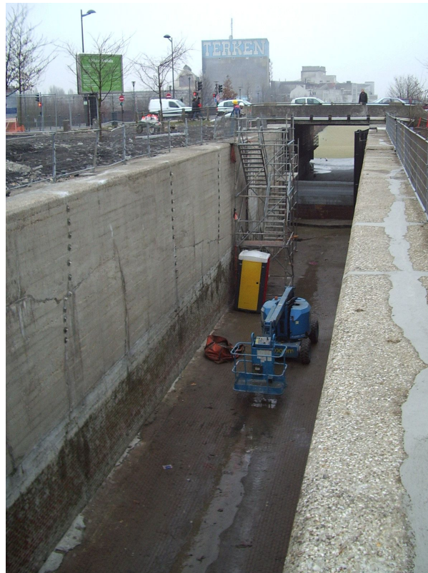
Travaux de rénovation de l'écluse.
