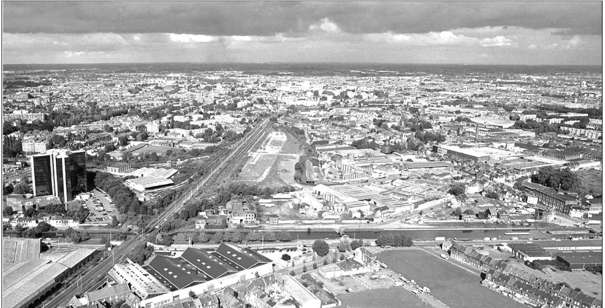
Vue aérienne vers 1978 de la zone de l'Union avant la démolition des friches industrielles. Seule l'ancienne gare SNCF est déjà en friche.
