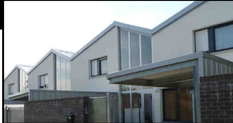
Maison serre : référence à l'architecture industrielle et toiture en sheds
