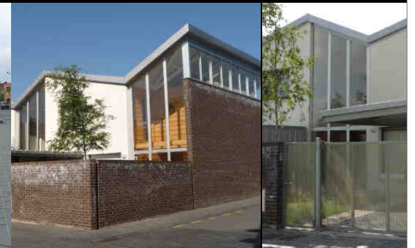
Mise en place de serres (éclairage et apport de chaleur)
