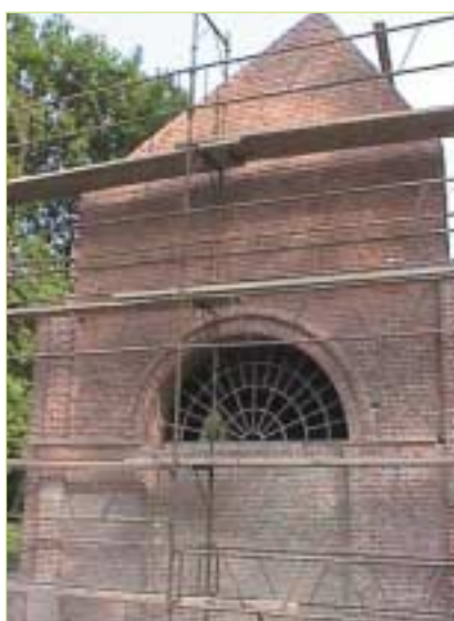
La réfection du pignon Nord-Ouest
