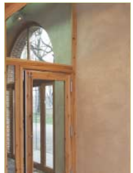
Enduit intérieur à la chaux
