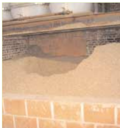
Silo de bois déchiqueté
