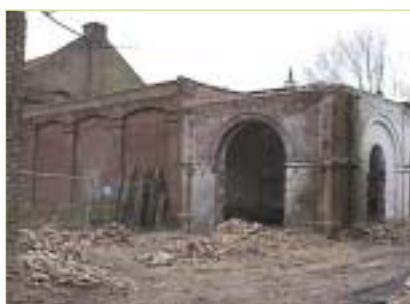
Déconstruction de la façade Sud-Est
