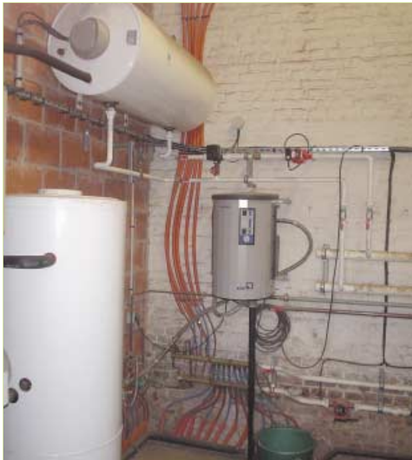
Système de gestion des eaux pluviales
