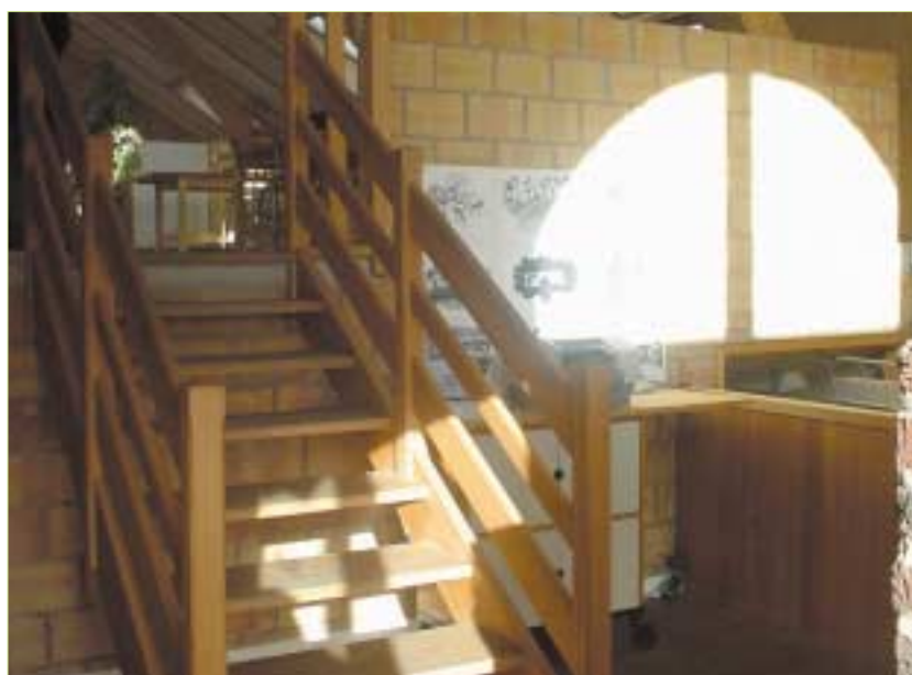
L'escalier et la mezzanine associent hêtre naturel et briques de terre cuite
