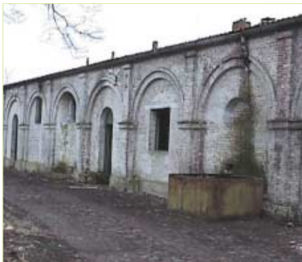
Les écuries avant travaux
