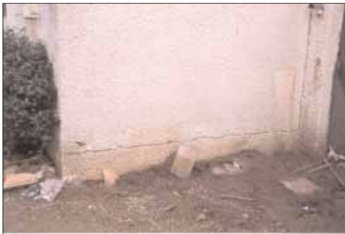
Fissuration horizontale
