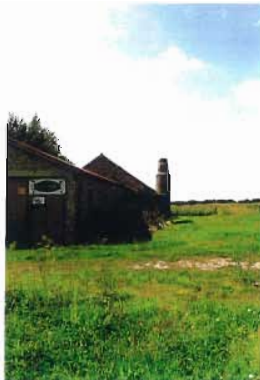
Ancienne Poterie Lempereur, sortie Nord-Est du village, Rue du Gal Leclerc.
