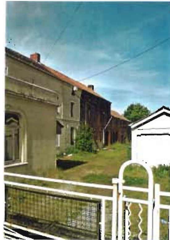
Bâtiments vacants Rue Jean Jaurès à deux pas de l'ancien site de la Poterie Maine
