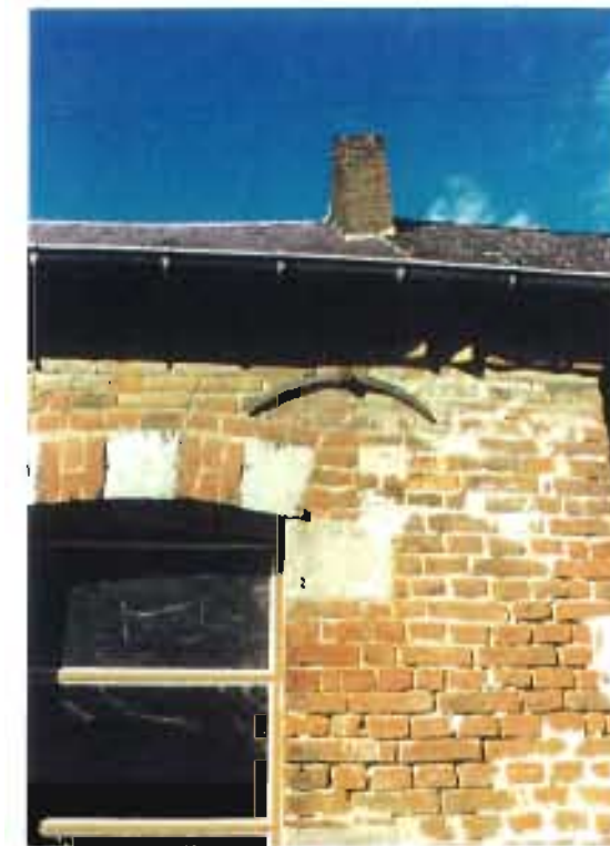
Appareillage en moellons et Chaînage d'angle en pierre, rehaussé au XIX ème par un appareillage en brique rouge à l'étage, avec modification de l'ouverture de la porte
