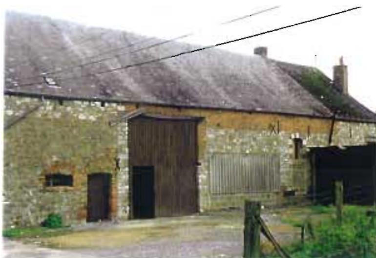
Ci-dessus et ci-contre: Habitat Rural Traditionnel de type ferme, utilisant les matériaux locaux, et réunissant sous un même toit le volume habitable, la grange et l'étable. On distingue nettement les rehaussements faits sur les volumes des granges et des étables, rejoignant ainsi le niveau du volume habitable dont les combles peuvent être réaménagés.
