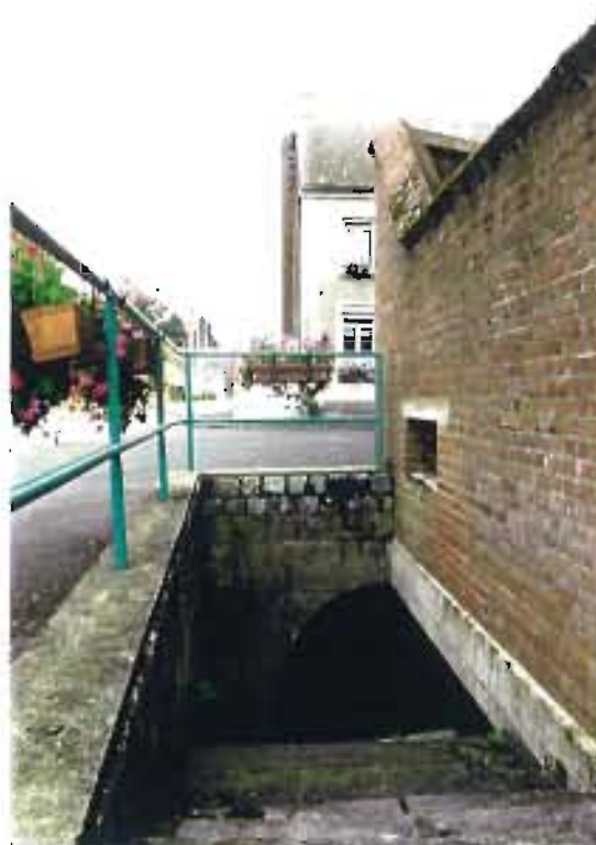
Lavoir en angle des rues de Doulers et Neuve
