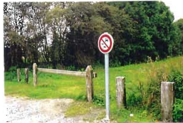
Ci-dessous l'axe vert inscrit au PDIPR, réalisé sur l'ancienne voie SNCF de Maubeuge à Fourmies
