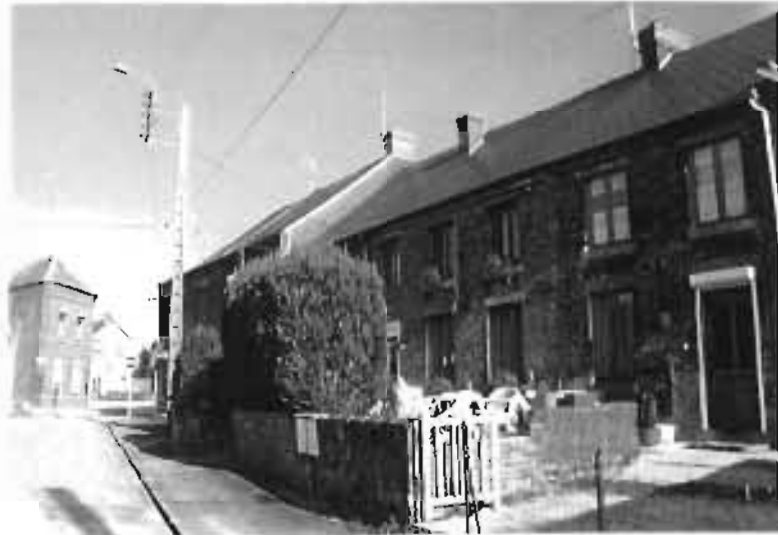
Exemple d'Habitat Ouvrier jointif avec jardins, ponctuant le débouché de la Rue Pasteur sur le carrefour du Cheval Blanc.
