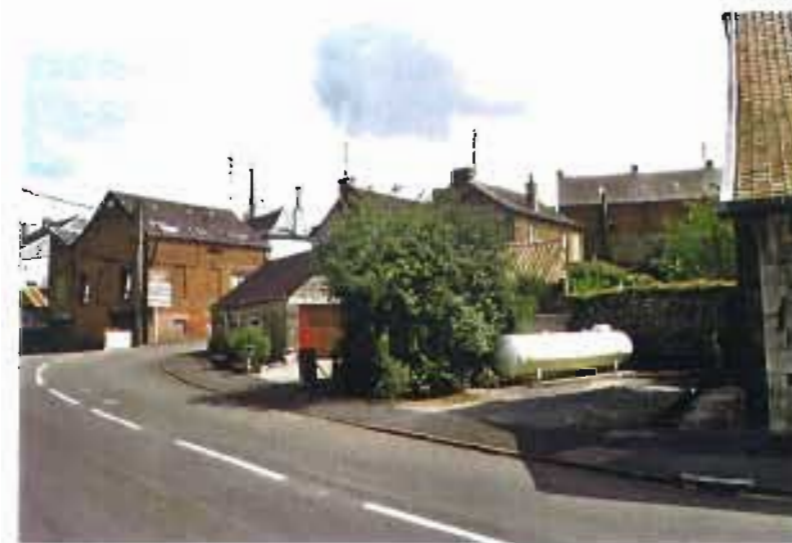
Les abords de l'ancien Atelier du Verre en berge Sud.
