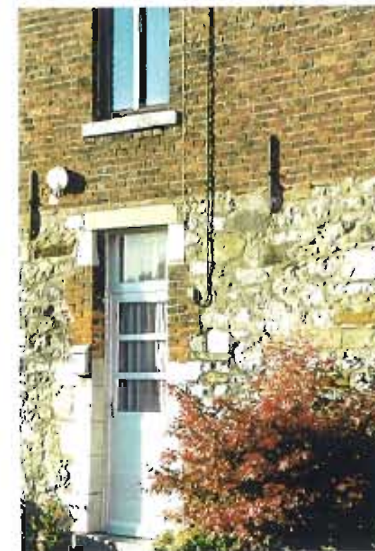
Appareillage en moellons et Chaînage d'angle en pierre, rehaussé au XIX ème par un appareillage en brique rouge à l'étage, avec modification de l'ouverture de la porte
