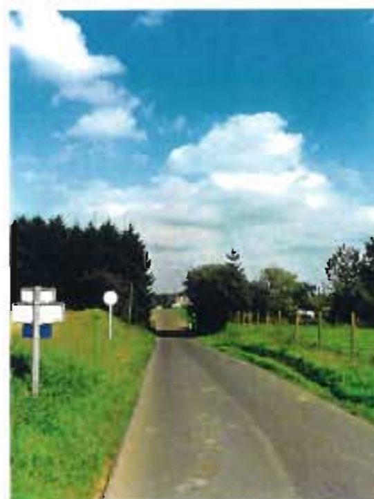
Entrée Ouest de la Commune par la Route de Dourlers (RD33) intersectant avec les boisements résineux de l'ancienne voie ferrée d'Avesnes à Sars Poteries
