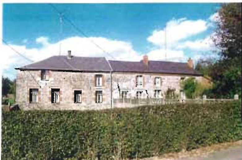
Ancien volume de ferme réalisé en matériaux nobles pierre de taille et moellon, et reconverti entièrement en habitation: modification ou reconstruction sur l'emprise initiale? Le percement des ouvertures et quelques différences dans l'appareillage de la façade nous ferait pencher pour la première option.
