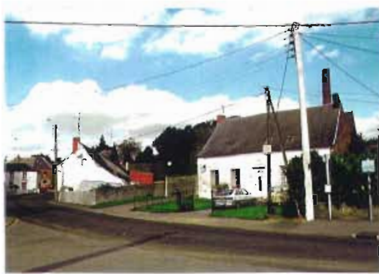
Arrêt de bus implanté dans l'incurvation Nord de l'axe.
