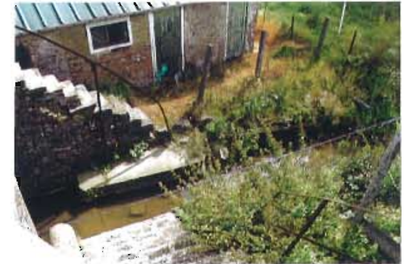
Emmarchement et Descente à l'eau du Pont Courlemain
