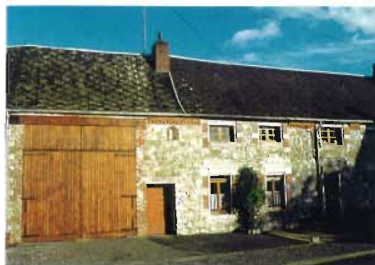
Ci-dessus et ci-contre: Habitat Rural Traditionnel de type ferme, utilisant les matériaux locaux, et réunissant sous un même toit le volume habitable, la grange et l'étable. On distingue nettement les rehaussements faits sur les volumes des granges et des étables, rejoignant ainsi le niveau du volume habitable dont les combles peuvent être réaménagés.
