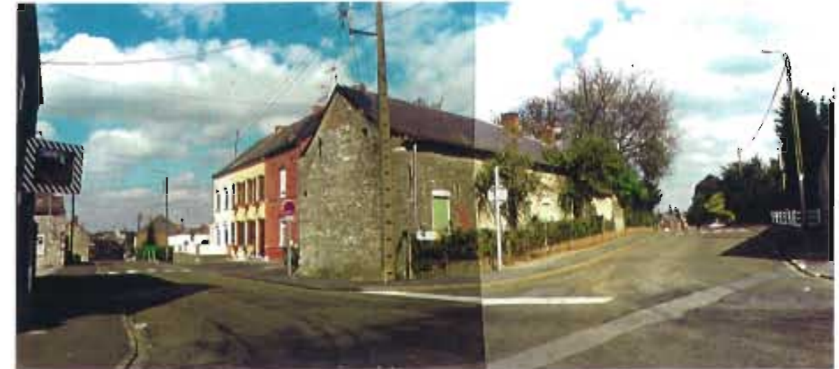
Panorama Intersection Rue Pasteur/Rue Jean Jaurès: Bombement du carrefour et Ponctuation de bâti rural.
