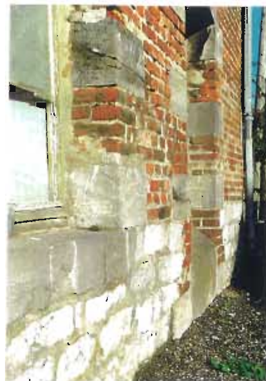
Soubassement en pierre de taille grossière, Linteaux en pierre bleue lisse.
