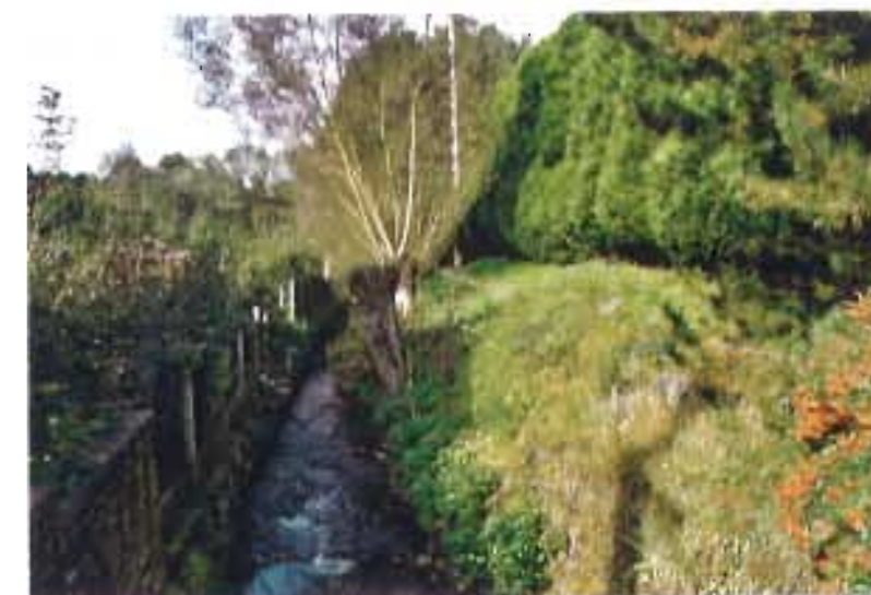
Berges érodées du Ruisseau du Moulin
