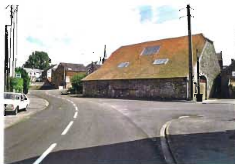
Un volume bâti imposant au débouché des rues de Dourlers et de Dimont
