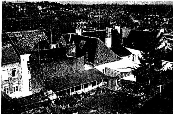
La création d'une terrasse au pied des remparts
