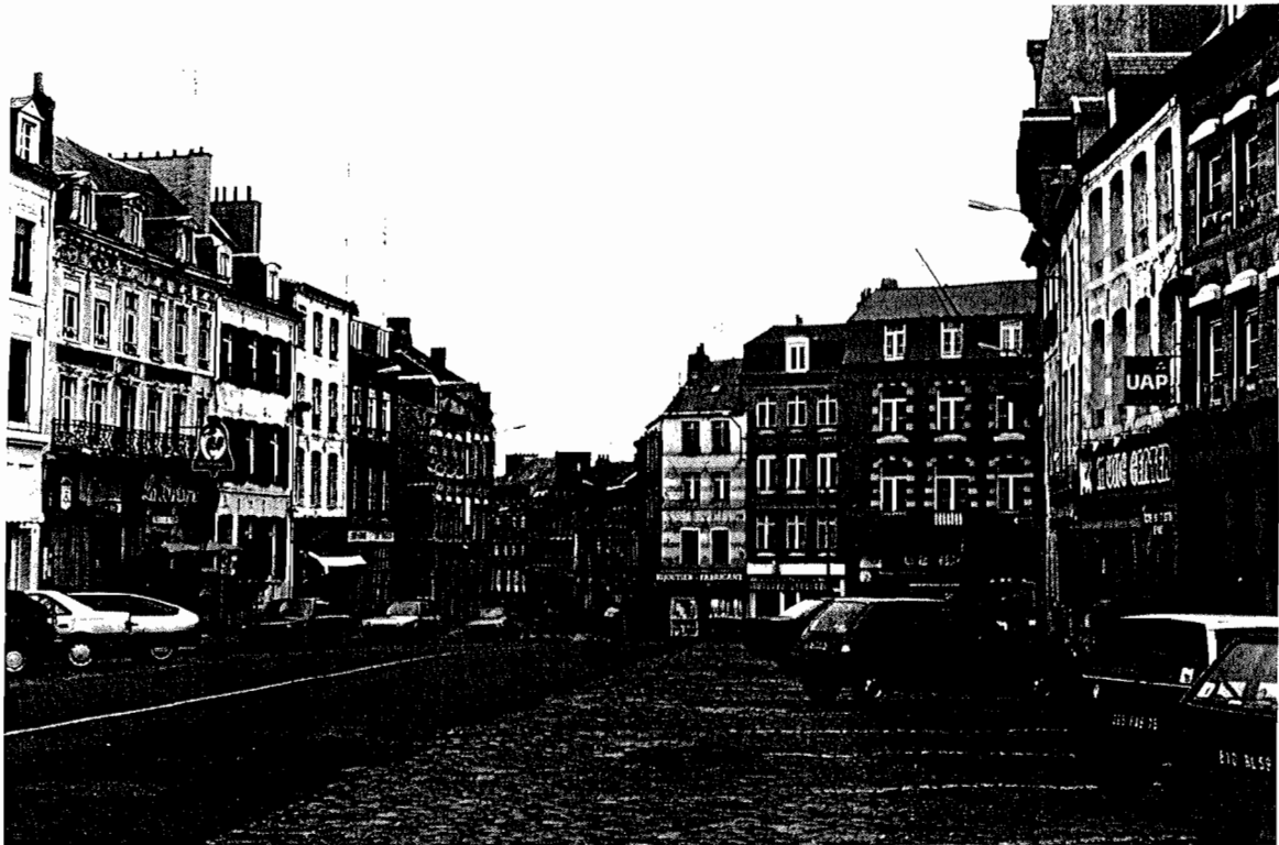
Front Ouest - Entrée de la rue V. Hugo
