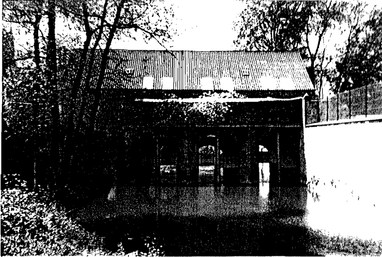
Pont des Dames, face amont
