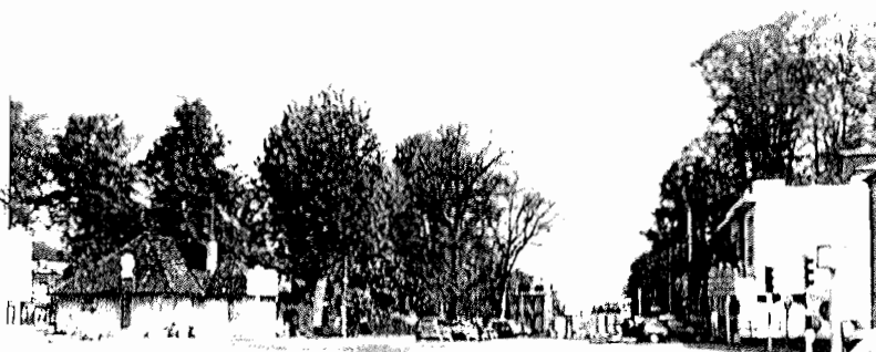
Entrée de Ville Sud Av. du Maréchal Foch
