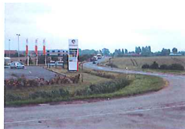
Une route de contournement, pourtant proche des activités économiques et sociales de la périphérie de Steenvoorde (sur le territoire de Terdeghem)
