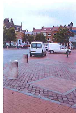
Le dessin au sol laisse paraître un défaut de concertation avec les riverains : deux arbres étaient prévus à ces emplacements
