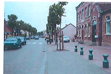
Des aménagements de sol en brique pour anticiper sur les réparations en cas d'intervention sur les réseaux souterrains
