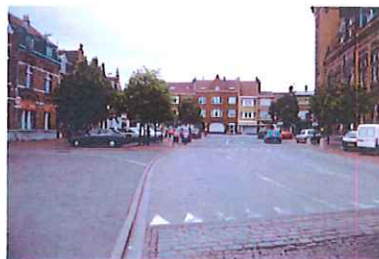
Des matériaux qui ont du mal supporter un trafic routier intense
