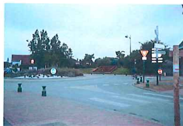
Un dispositif de giratoire avant l'accès au centre-ville situé à l'intérieur des fortifications
