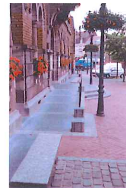
Des aménagements mettant en valeur l'entrée de l'hôtel de ville et pourtant jugés glissants
