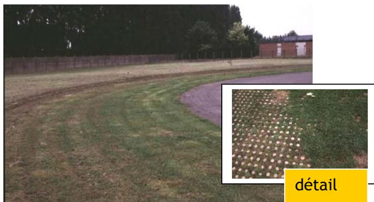
**Des dalles de béton** arment un gazon qui est utilisé comme parking pour les visiteurs et le personnel. Cette solution permet d'obtenir un effet « vert » important. Elle n'est malheureusement pas adaptée pour des stationnements permanents. Cette technique réduit également les ruissellements.
