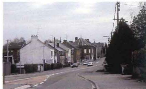
L'alignement du bâti à l'entrée du village depuis Glageon.
