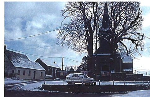
La zone de parking et le parvis de l'église.
