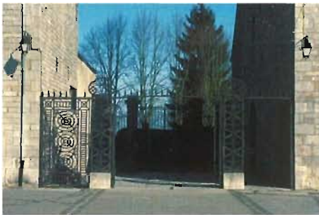
Le parvis intimiste de l'église protégé par sa grille, véritable sas entre la place et le cimetière et "antichambre" de l'église.
