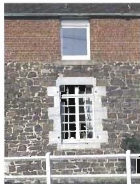
Une ferme comportant un demi-étage : une maçonnerie en grès réhaussée d'un surcroît en brique.
