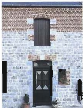
Une ferme comportant un étage : une maçonnerie en pierre réhaussée d'un surcroît en brique.
