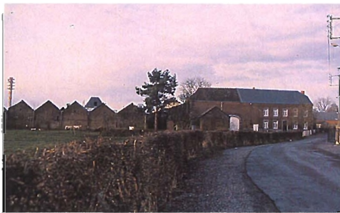
L'arrière de l'usine, en partie disparue aujourd'hui.
