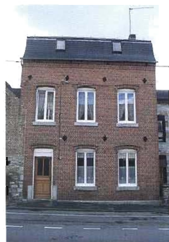
Maison du XX e , la pierre bleue n'est plus qu'occasionnellement utilisée dans les encadrements.
