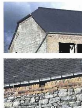
Un quart de croupe dit « nez cassé » prolongeant la toiture sur le pignon et une corniche denticulée.
