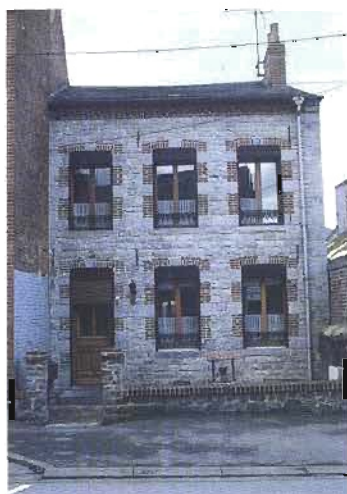
Maison du XVIII e en maçonnerie de pierre bleue et encadrement de briques.
