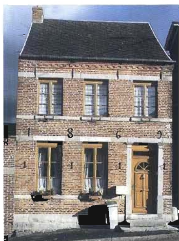
Maison du XIX e , la brique devient le matériau de maçonnerie prédominant.
