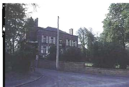
La Maison du Bocage à Sains-du-Nord.
