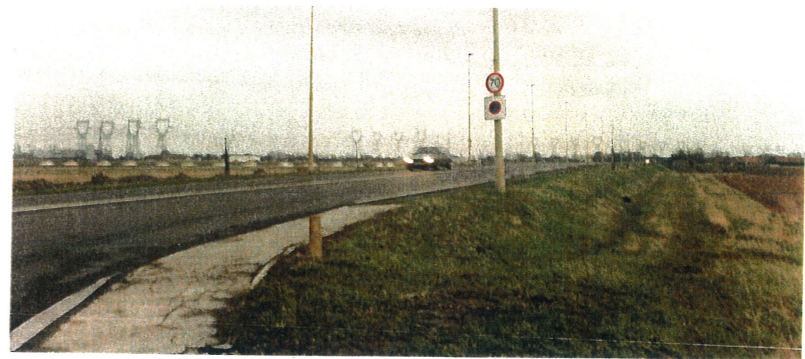
La coupure de la digue Level reliant les Huttes à la centrale au travers du polder.
