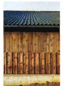
Le bardage sera par exemple posé de façon originale au niveau du pignon et des portes. Des détails de construction, bien finis et apparents contribuent à mettre en valeur l'ensemble.
