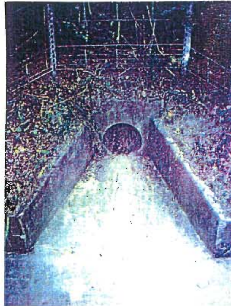
Passage petite faune - En absence de grillage, le passage est malgré tout régulièrement utilisé par le blaireau
