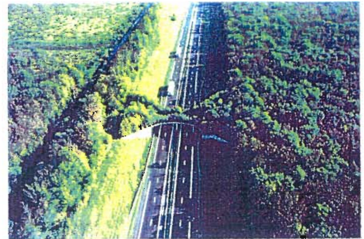
La connexion est rétablie : le passage est parfaitement fonctionnel pour le chevreuil, le sanglier et l'ensemble de la petite faune forestière.
