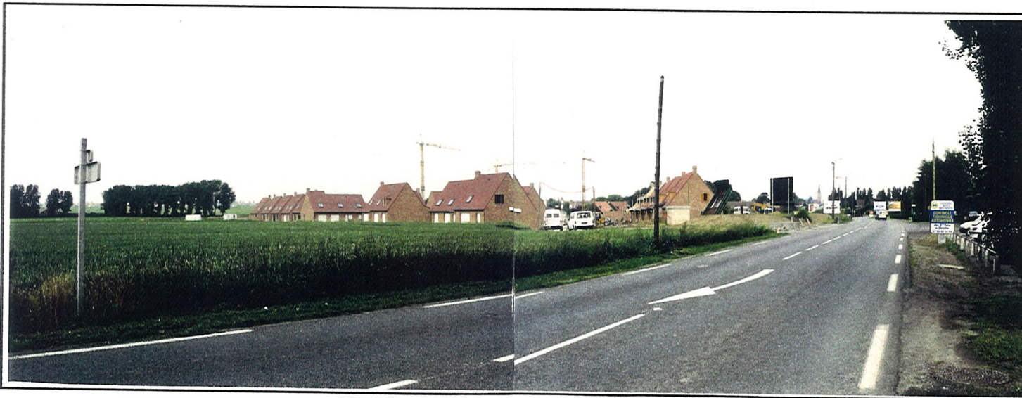
L'entrée Ouest. Lotissement "Les Charmilles" en construction
