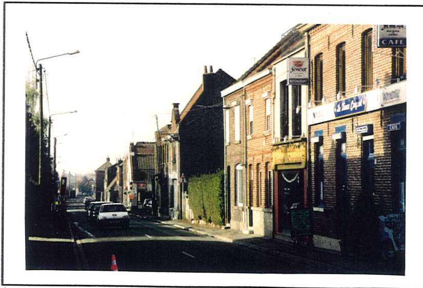
Bâti ancien Rue de Seclin
