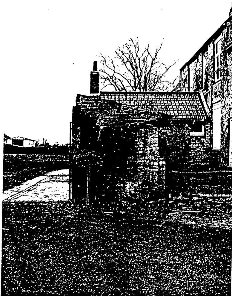
L' appareillage sensiblement différent des briques sur le pignon Est du fournil remet en cause l' authenticité de la toiture en tôles .
