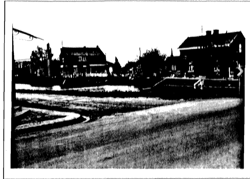
Chemin de halage direction ouest
