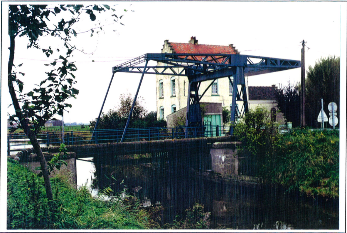
Ancien pont basculant
