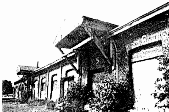
La façade côté centre ville
