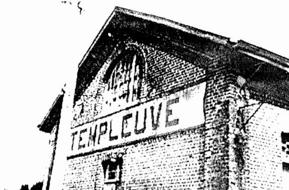
Le pignon et sa fenêtre en plein cintre
