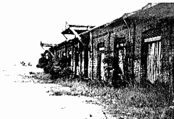
La façade côté voies SNCF
