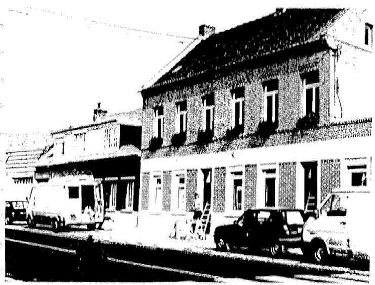
⑦ la mairie : - en cours de ravalement - projet de restructuration après le déménagement des écoles
