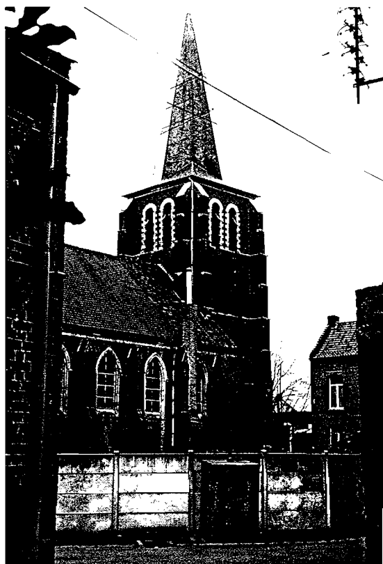
Une clôture béton rue Gambetta, ferme l'espace à l'arrière de l'église.
