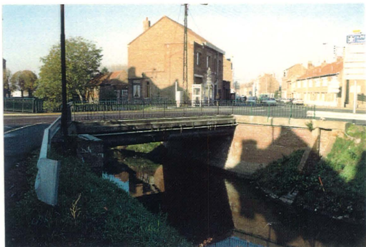
Le pont des Morts, à l'entrée Nord, qui fait l'objet d'une étude d'élargissement pour doubler sa capacité de franchissement de la Bourre.
