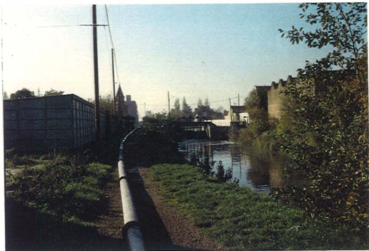
← Cheminement en bord de Lys, en aval de l'écluse.
