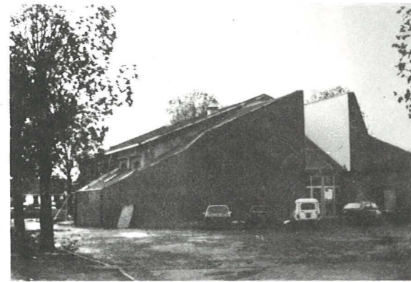
SALLE DES FETES (en chantier)
