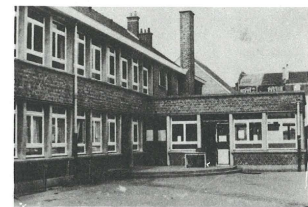
ECOLE RUE DES PRETRES
