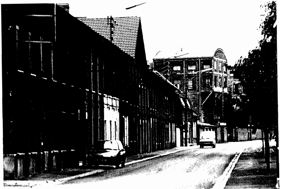
Rue de Masny : la friche industrielle sera détruite, les terrains plantés.
