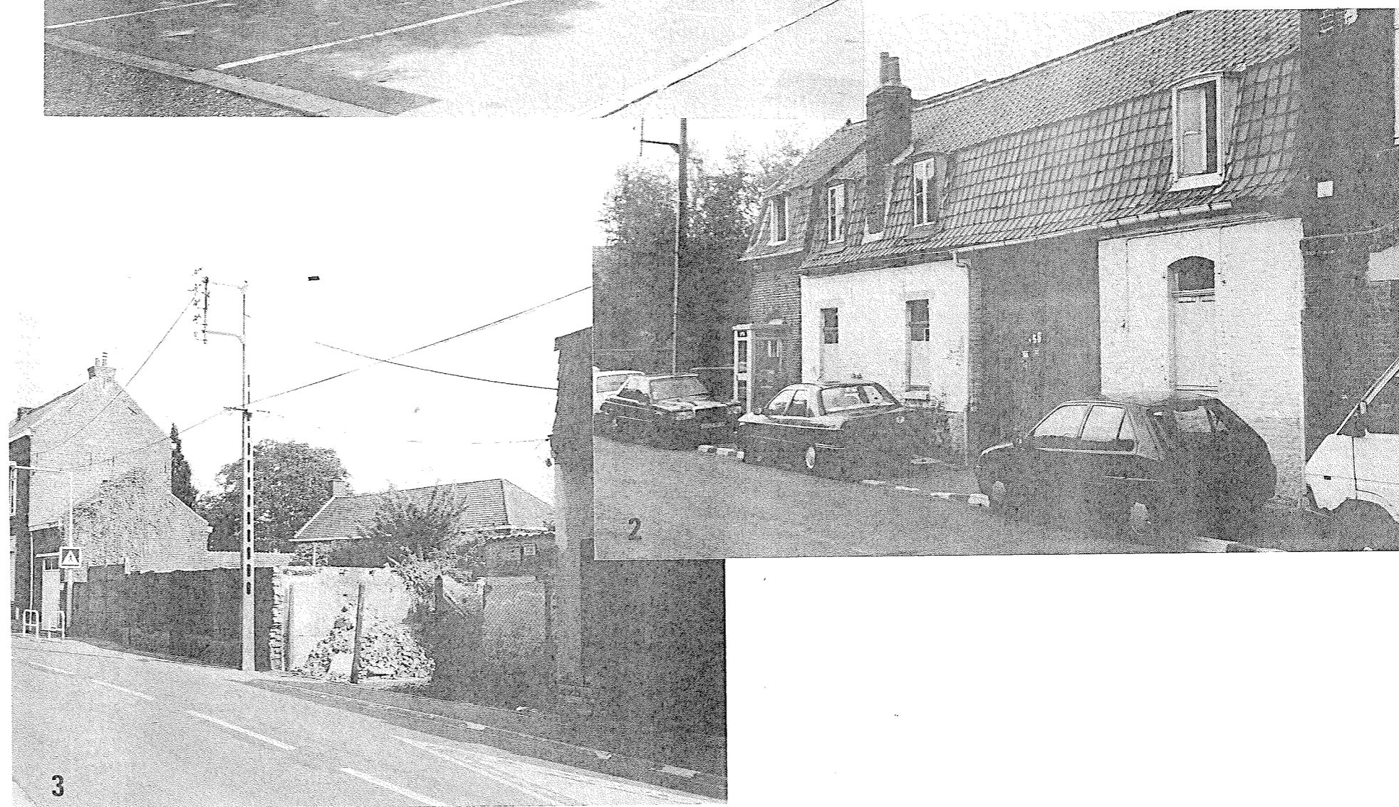
photographies "rupture" face au Parc J.J. Rousseau bâtiment dégradé et ruine au 332 rue R. Salengro et 71 rue J. Jaurès.
