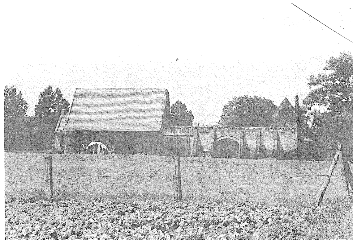
photographie de la ferme de la Pouillerie
