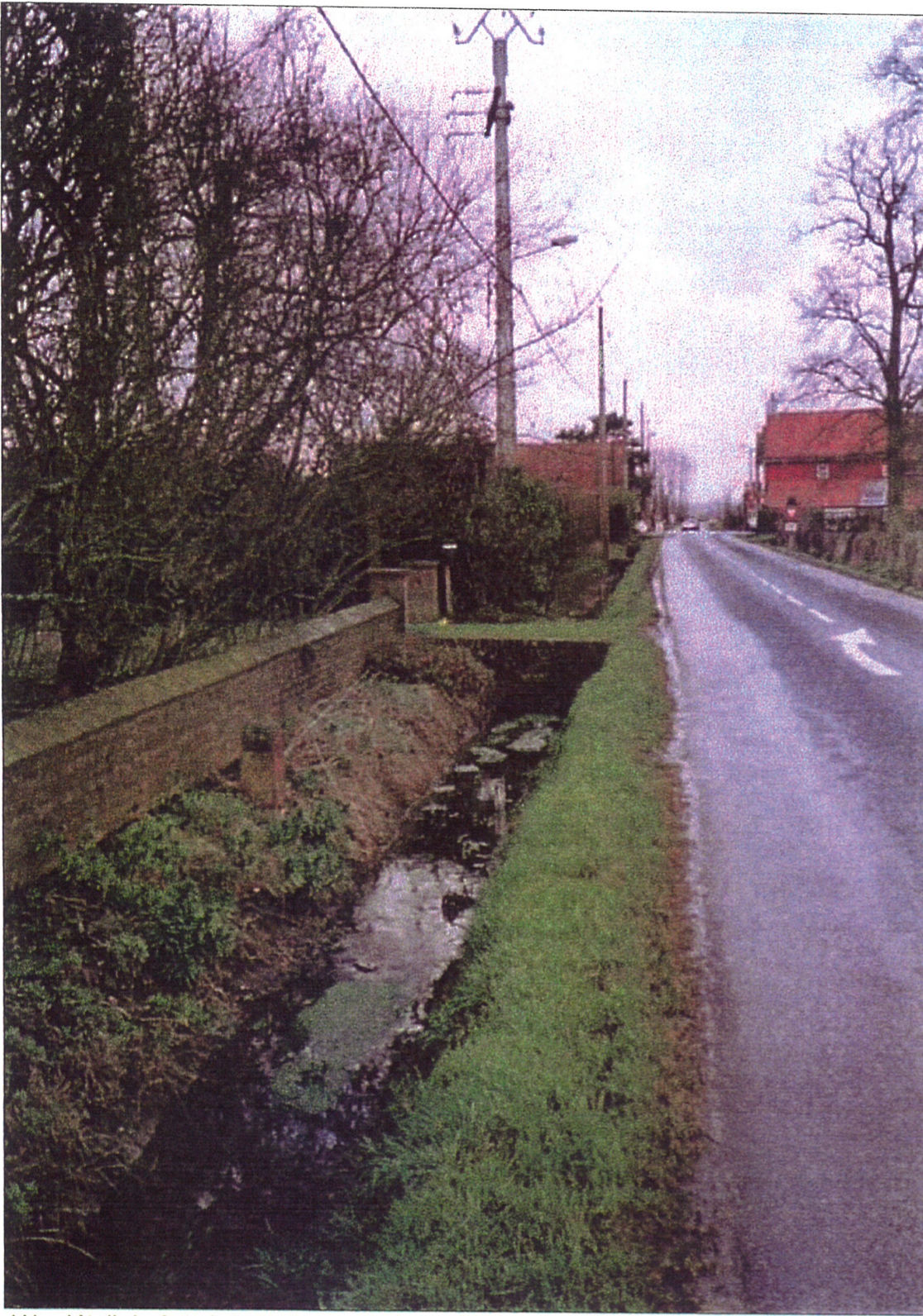
1 / le détail du fossé donne une grande qualité à ce bord de route
