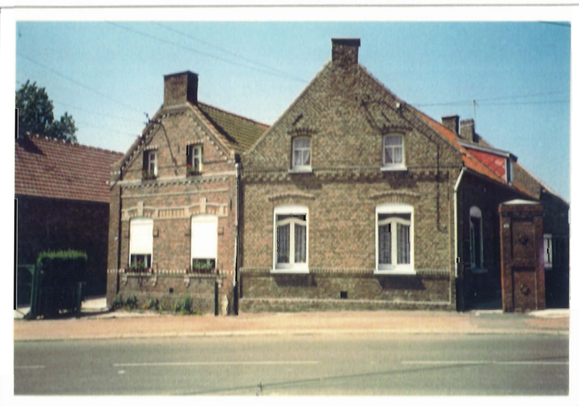
L'appareillage des pignons ainsi que la pose des briques sont ici remarquables.
