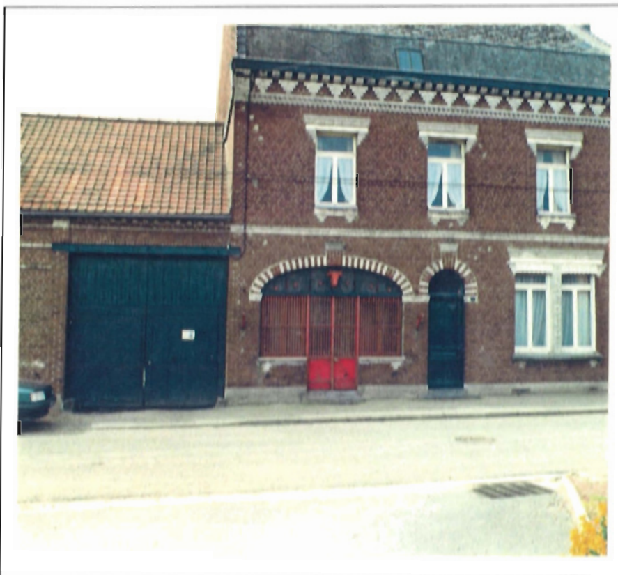
Ancienne boucherie de la rue du Bois
