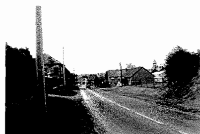
La rue Delaporte : retravailler les accotements
