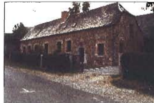
Rue du cimetière : toiture avec croupe, appareillage horizontal, ici, la configuration de l'étage est différente, d'où une maçonnerie de brique plus importante.
