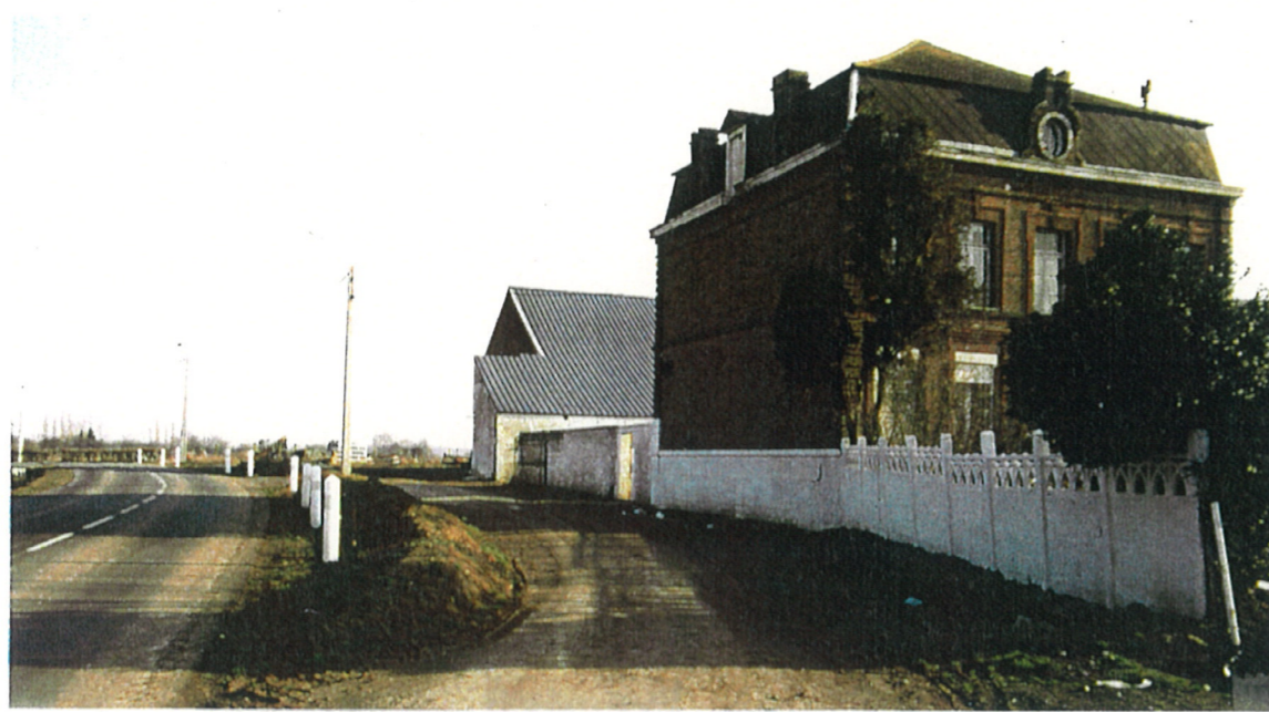
FERME DU LION : Coexistence d'un habitat d'une certaine qualité architecturale et d'un délaissé routier, offrant la Possibilité d'intégrer le bâti agricole, et réfléchir à la sécurisation (secteur accidentogène).
