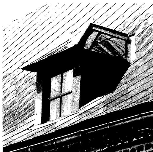
Elle s'appuie sur une panne de la charpente et repose sur les chevrons. Sa toiture est en croupe, recouverte d'ardoises et le faîtage est terminé par une tuile vernissée posée en cavalier.
