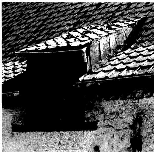
Une autre trouée est pratiquée dans la toiture pour le conduit de cheminée. Le plus souvent, lorsque le logis compte deux pièces de profondeur, les conduits se rejoignent à l'intérieur, sous les combles, pour former une souche commune débordant du toit au niveau du faîtage.
