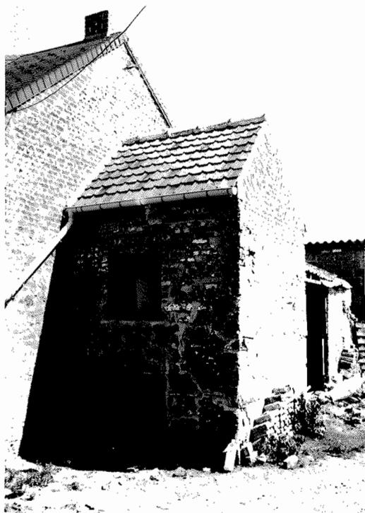
Le toit est suffisamment haut pour ménager au-dessus de la voûte du four, un séchoir ou une réserve à fagots.
