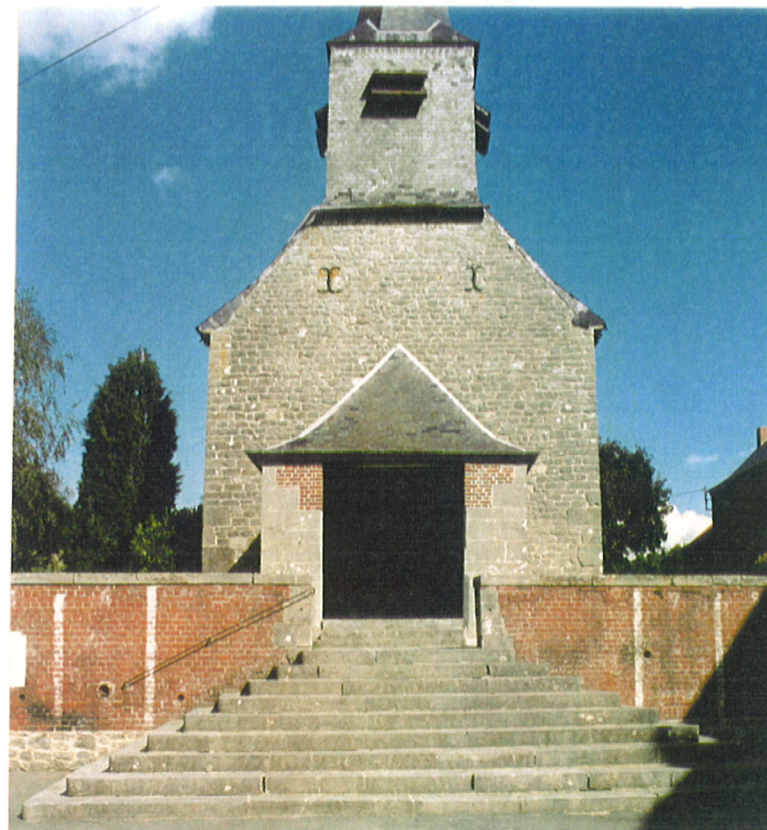
Emmarchements d'accès à l'Eglise, Murs et murets... Autant d'éléments patrimoniaux à affirmer
