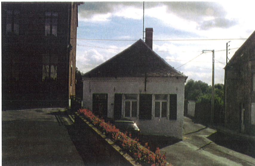
Dénivelé entre les deux portions de la Place Centrale
