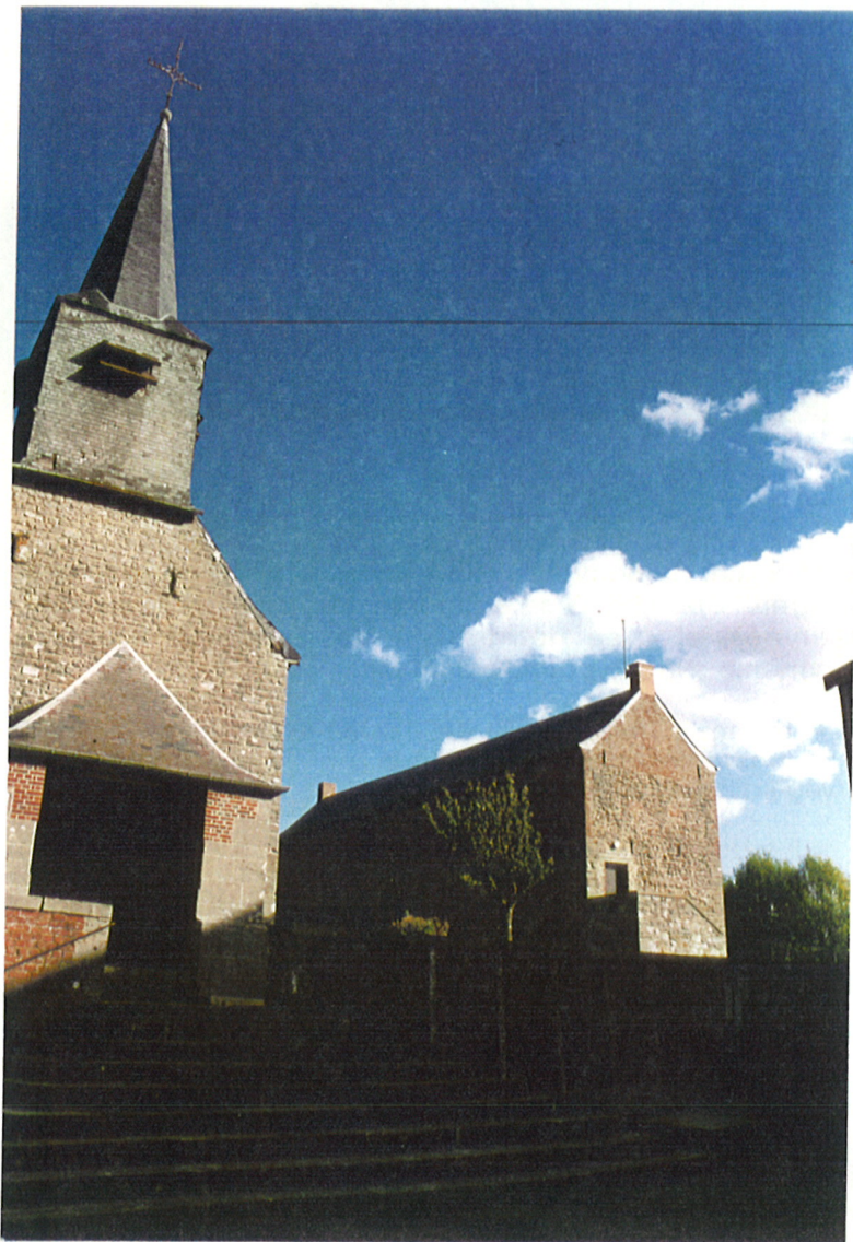
Façade Nord du Presbytère depuis la Place Centrale
