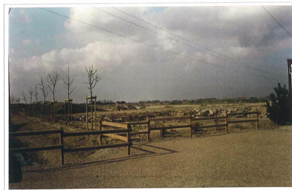
Extension en cours de la zone artisanale
