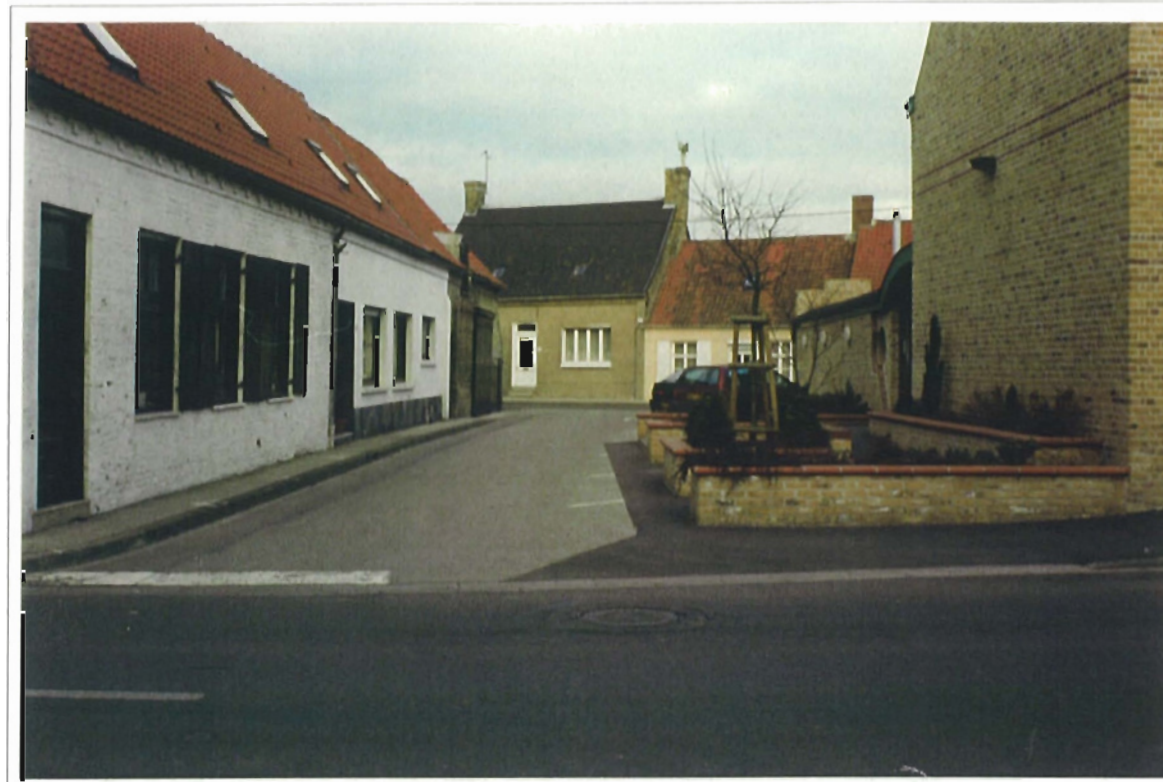
Intégration de bâtiment en arrière de l'école
