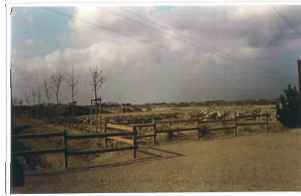
Extension en cours de la zone artisanale
